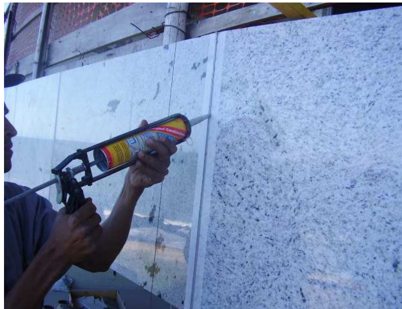
Aplicação de Mastique na Junta
