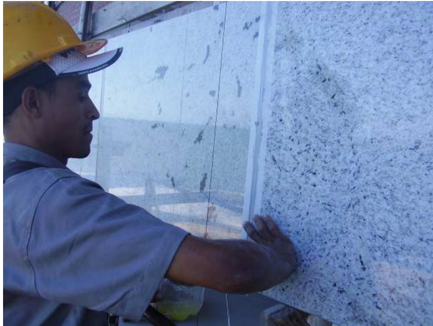
Remoção do Excesso de Mastique
