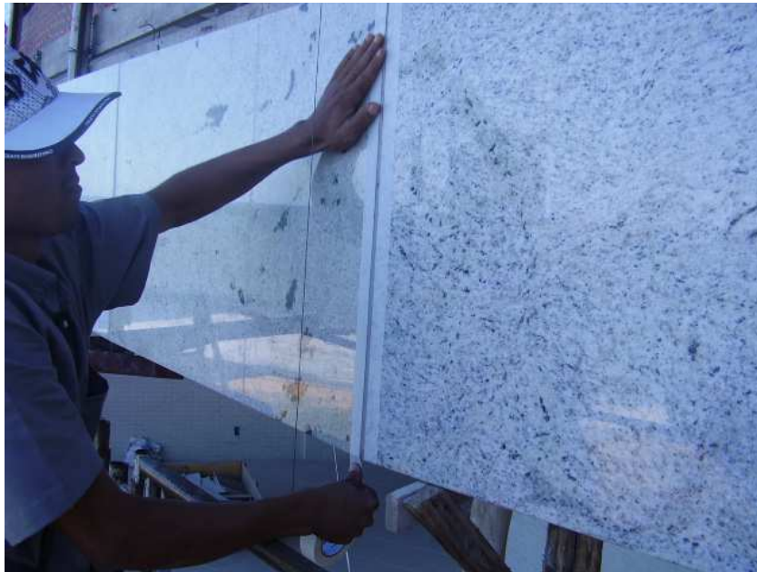
Aplicação de Fita Crepe na Junta
