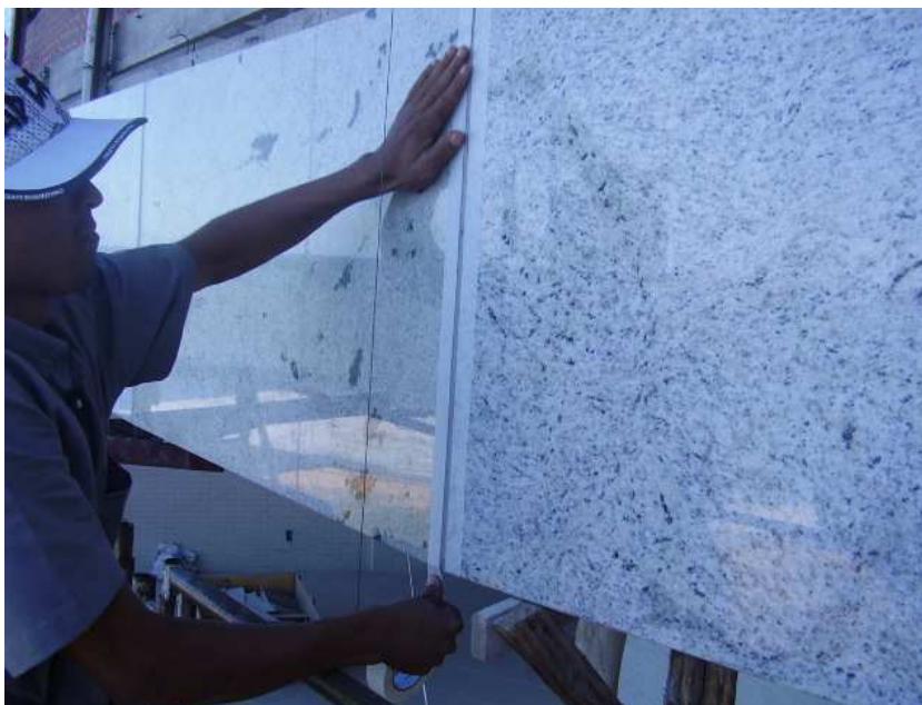
Aplicação de Fita Crepe na Junta
