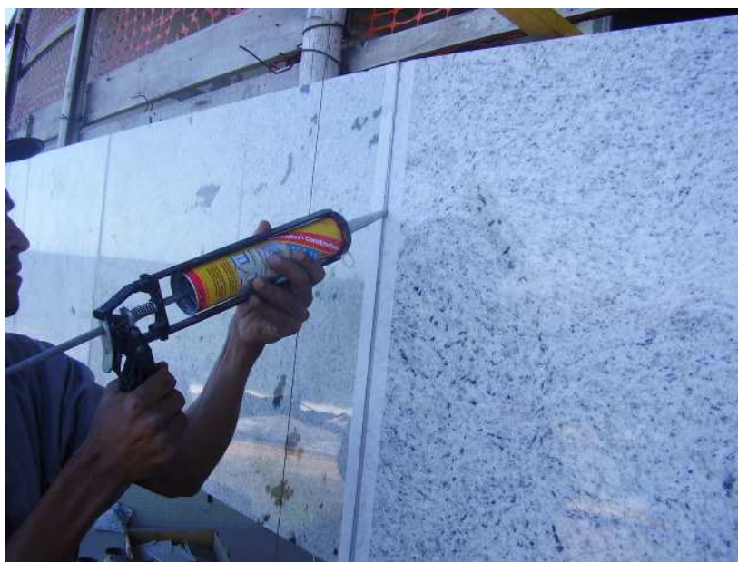
Aplicação de Mastique na Junta
