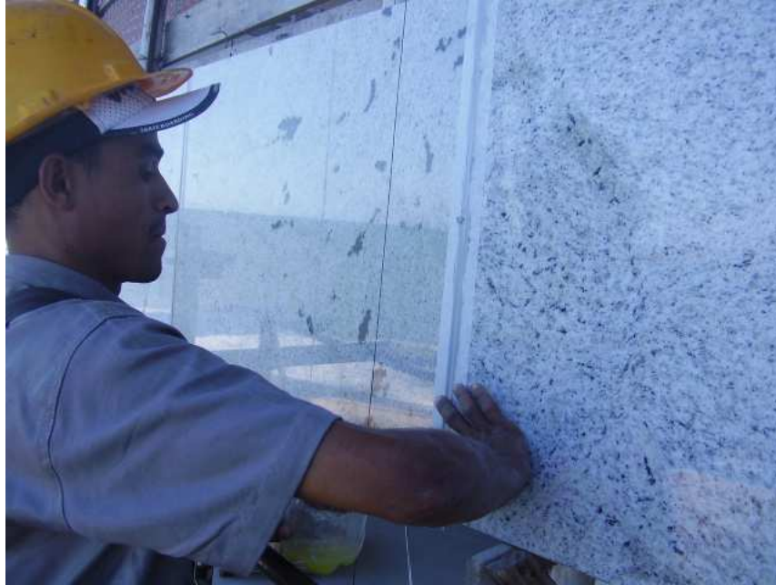
Remoção do Excesso de Mastique
