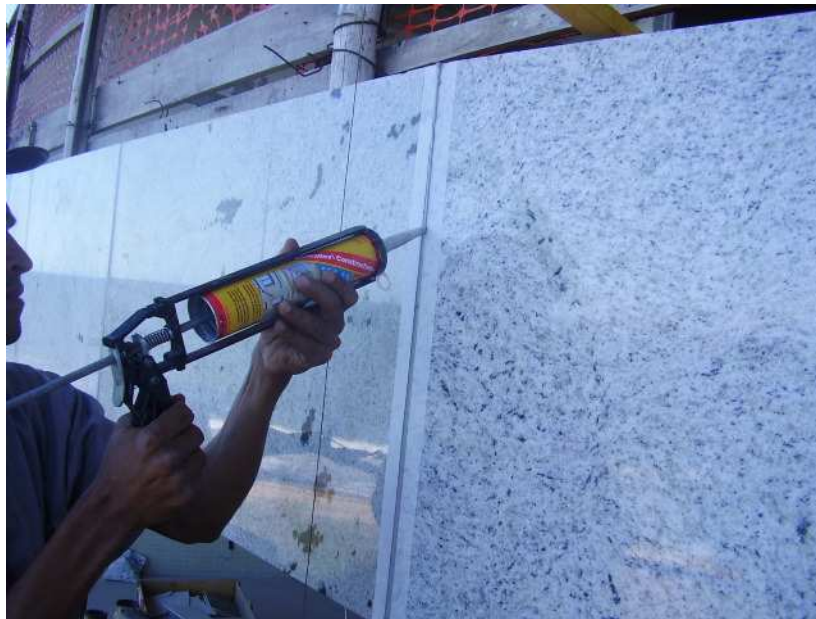
Aplicação de Mastique na Junta
