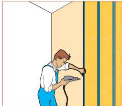
Passo 08 – Fixação de placas em um dos lados
