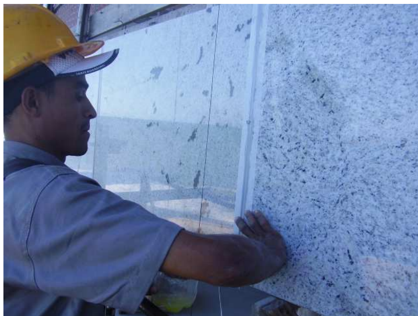
Remoção do Excesso de Mastique
