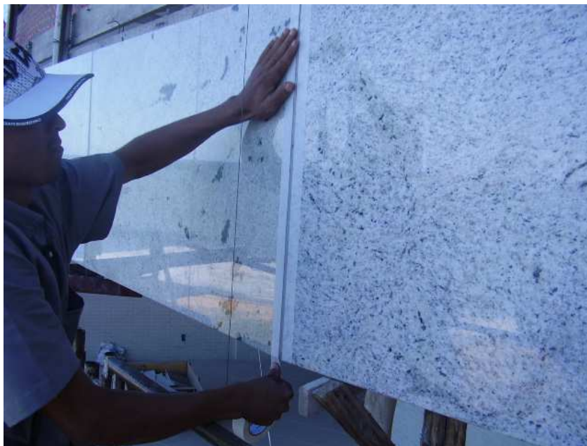
Aplicação de Fita Crepe na Junta
