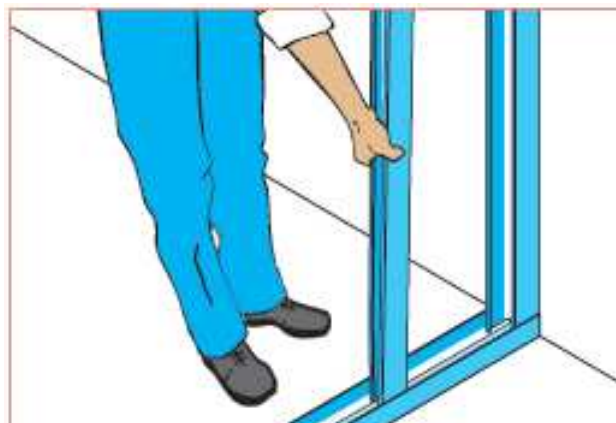
Passo 02 – Locação e fixação de montantes
