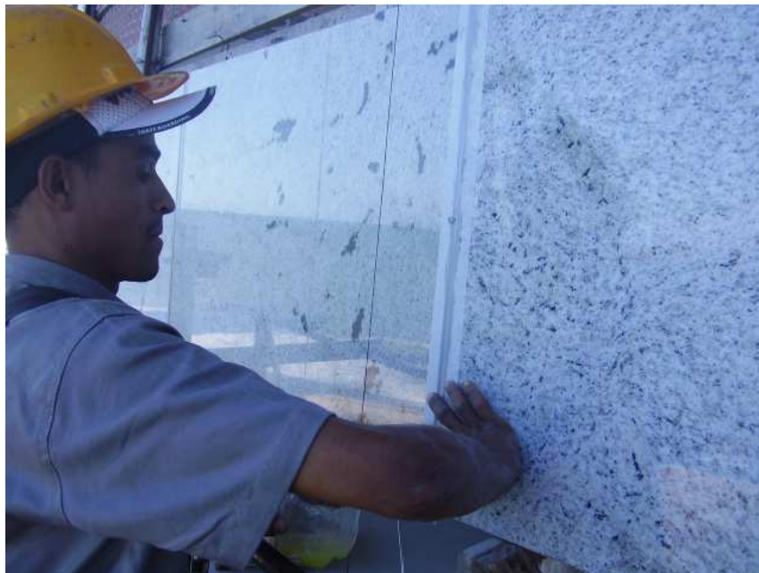
Remoção do Excesso de Mastique
