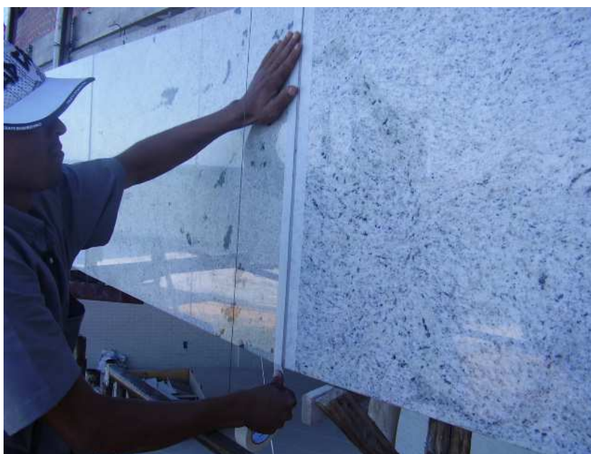
Aplicação de Fita Crepe na Junta
