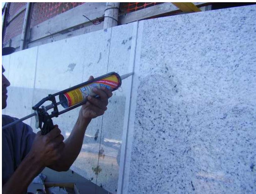
Aplicação de Mastique na Junta
