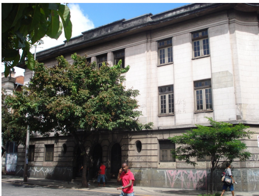
FIGURAS 27 e 28 - Vidros - aberturas voltadas para a Rua da Bahia e para a Rua dos Guaicurus. Ed. Mário Werneck
