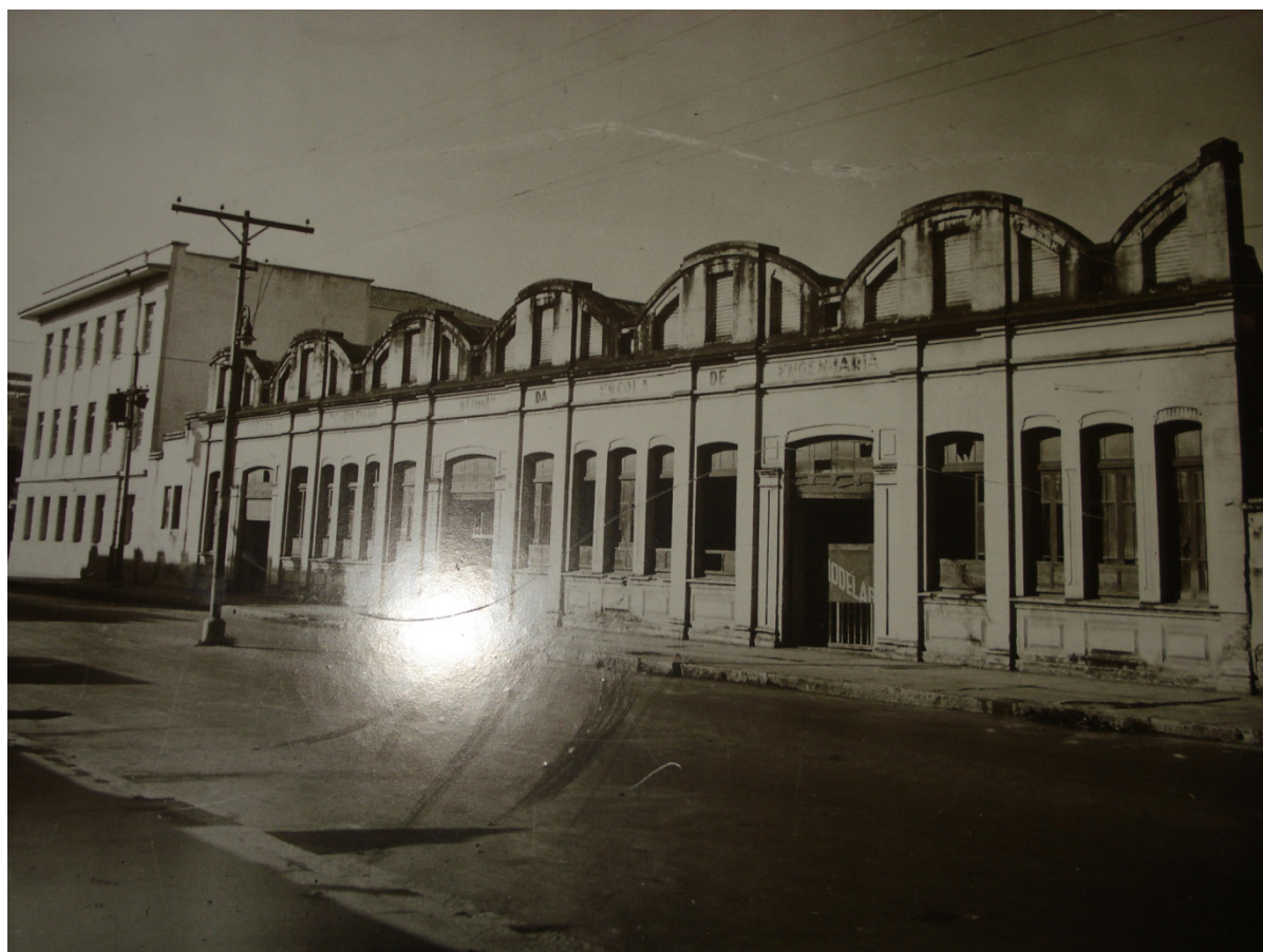
FIGURA 33 - Esquadrias da empena da fachada. Oficinas Cristiano Ottoni
