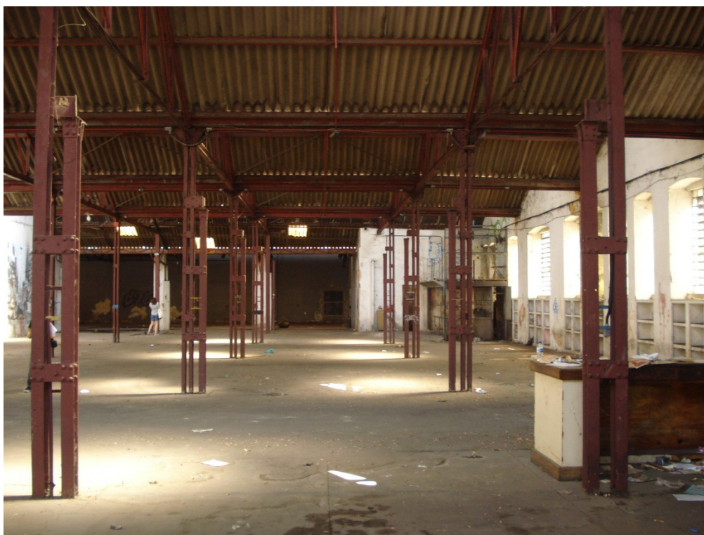
FIGURAS 29 e 30 - Estrutura. Oficinas Cristiano Ottoni
