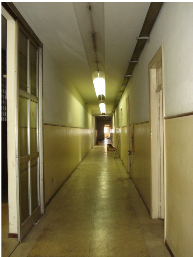
FIGURA 1 - Alvenaria de vedação Ed. Arthur Guimarães
