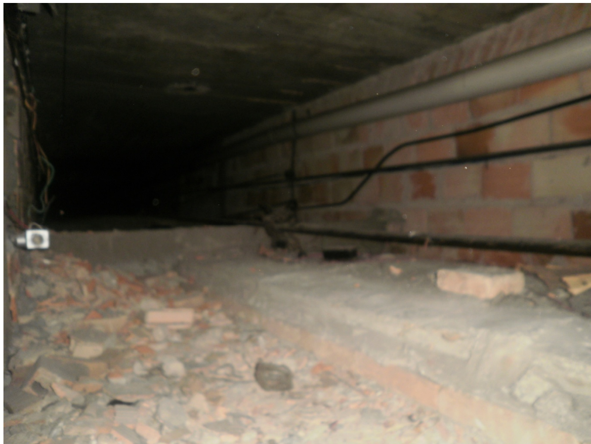
FIGURA 16 – Forro em laje caixão perdido da circulação.
